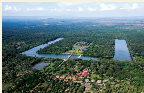
◀ヘリ空撮（駐車場と土産物屋群が見える） 2023年5月
